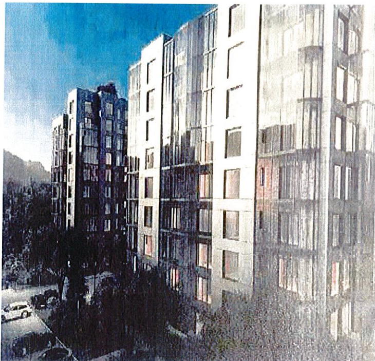
- fatada blocului conform stadiului actual -
